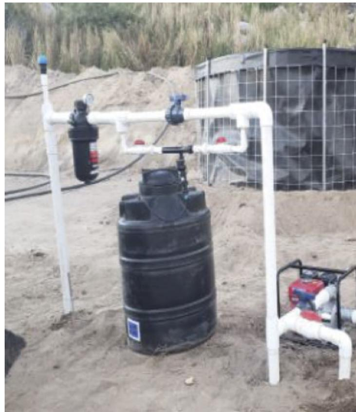
Ilustración 7 Cabezal de riego con Venturi y toma de presión
